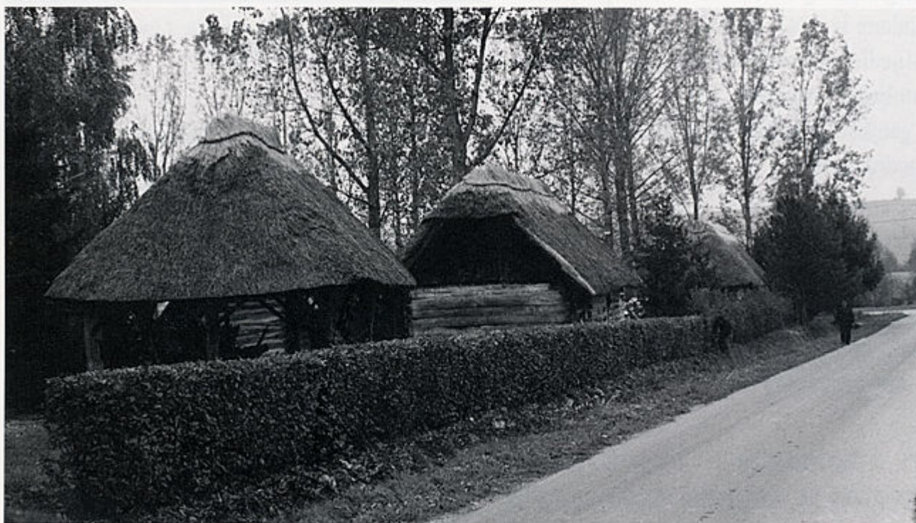
1. Obnova krova u Etno-naselju Ozalj, 1994. god. Zavičajni muzej Ozalj
