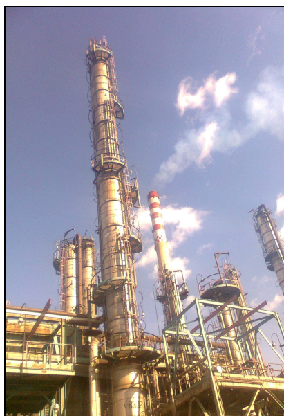
Slika 3a: Destilacijska kolona za izdvajanje benzena
