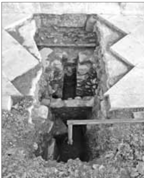
Slika 9. Revizijsko okno antičkog kanala unutar sonde uz istočnu kolonadu Peristila
