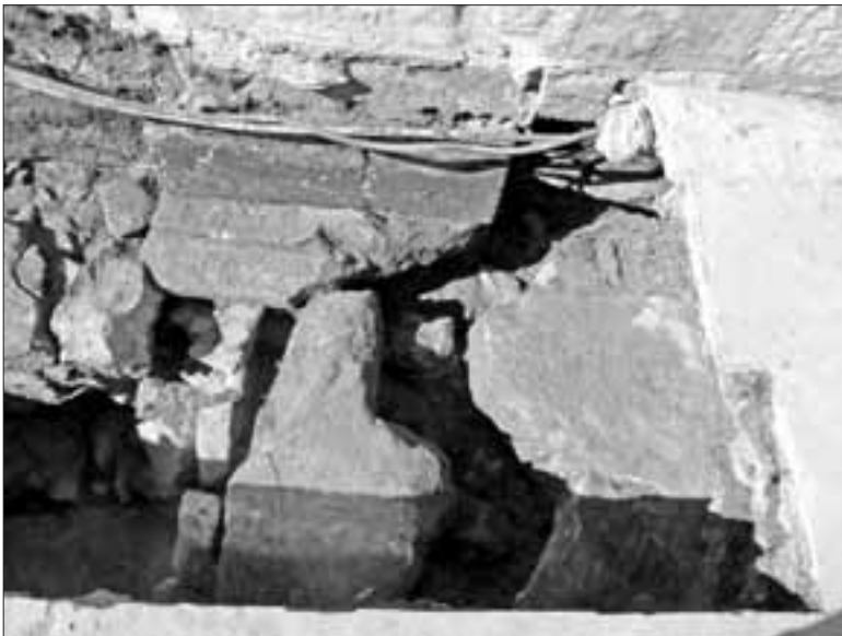
Slika 8. Rascijepljeni blok tetrapilona i spolija u temeljima pilona
