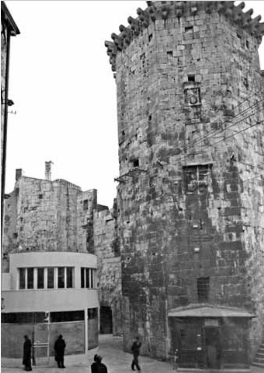
Slika 5. Niko Armanda: Poslovno - trgovačka zgrada na kraju niza dućana, Trg braće Radića u Splitu, 1935. (srušena 1945.)
