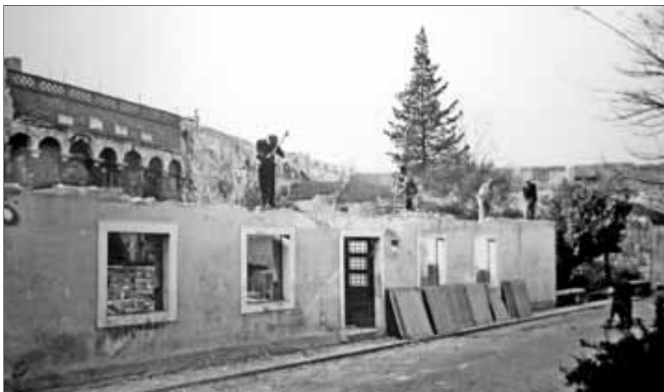
Slika 6. Uklanjanje porušenih nadogradnja na sjevernom pročelju Palače 1946. godine (K.I-a-432)
