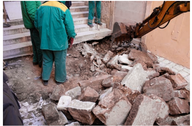
Sl.2b Strojno i ručno skidanje popločenja prije iskopa u donjem dijelu Uspona Frana Glavinića oko kućnog broja 1 - 2 (foto: R. Zlatunić) Fig. 2b Machine and manual pavement removal before the actual excavation in the lower section of the Fran Glavinić Gradient, around houses number 1 - 2 (photography R. Zlatunić).
