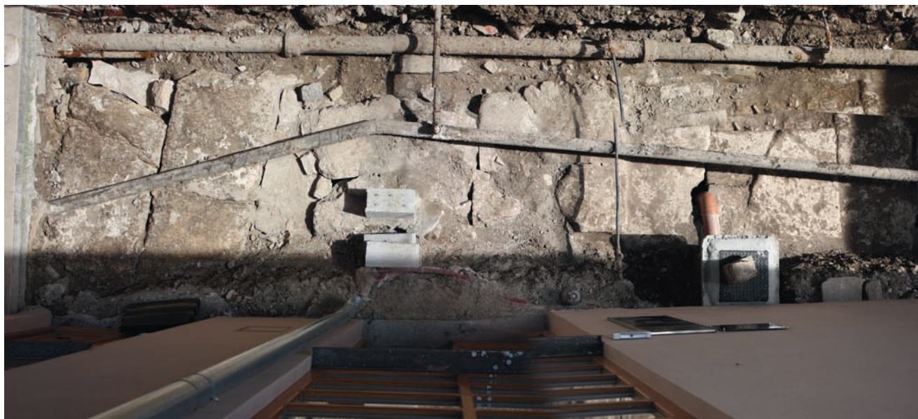
Sl.3a Pogled na iskopani dio antičkog radijalnog popločenja u donjem dijelu Uspona Frana Glavinića, oko kućnog broja 1 - 2 (foto: R. Zlatunić) Fig. 3a A view of the excavated portion of a pavement from a Roman radial road in the area of the lower section of the Fran Glavinić Gradient, around houses number 1 - 2 (photography R. Zlatunić).
