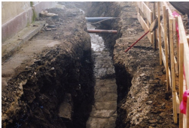
Sl. 7f Pogled na iskopan kanal u Ulici Castropola i vidljive ploče antičke ceste tijekom arheoloških istraživanja 1999. godine (foto: R. Zlatunić, fotoarhiva Arheološkog muzeja Istre)
