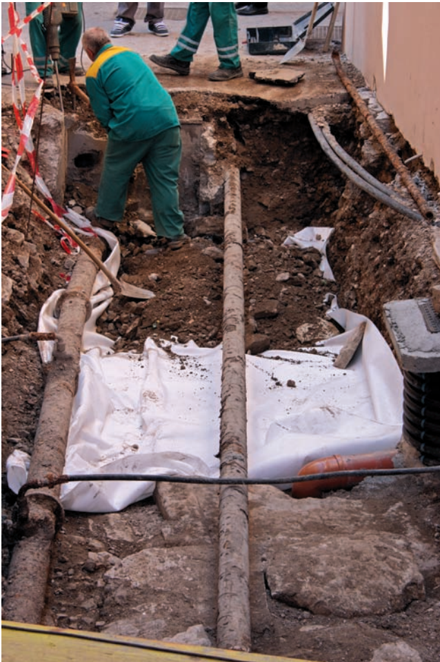
Sl. 4a Prekrivanje dijela antičkog popločenja geotekstilom i zatrpavanje iskopa (foto: R. Zlatunić)
