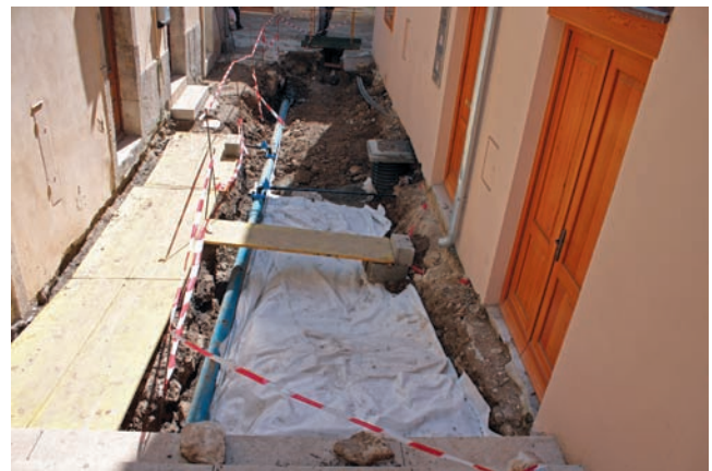
Sl. 4c Prekrivanje iskopanog antičkog popločenja geotekstilom i zatrpavanje iskopa (foto: R. Zlatunić)
