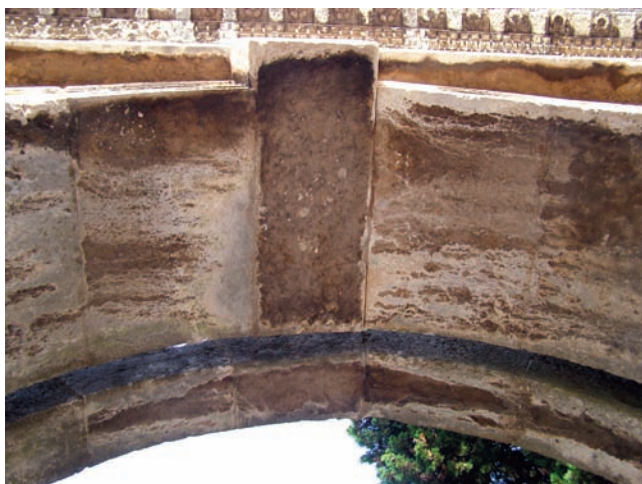
Sl. 8 Primjer crnih inkrustacija na Dvojnim vratima Fig. 8 An example of black incrustations on the Double Gate.
