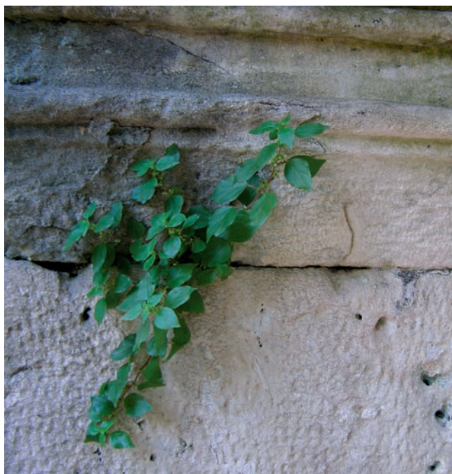
Sl. 9 Primjer tipične vegetacije prisutne na Dvojnim vratima Fig. 9 An example of typical vegetation present on the Double Gate.
