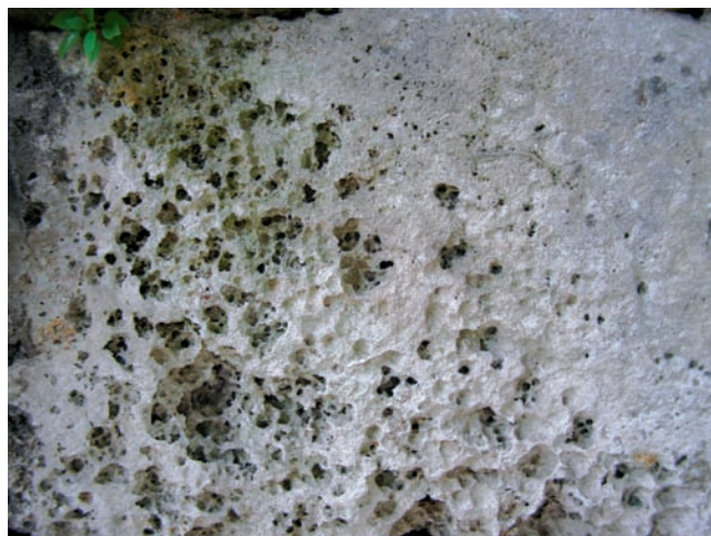
Sl. 11 Primjer alveolizacije, izuzetno raširenog vida degradacije Dvojnih vrata Fig. 11 An example of alveolization, a very widespread form of degradation on the Double Gate.
