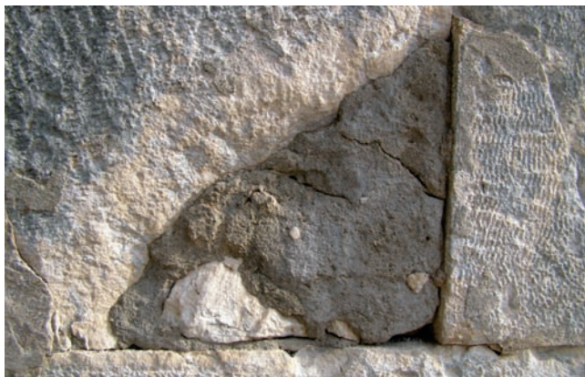
Sl. 14 Primjeri cementnih ispuna na Dvojnim vratima Fig. 14 Examples of cement fillings on the Double Gate.
