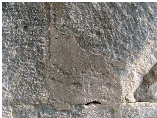
Sl. 15 Primjeri cementnih ispuna na Dvojnim vratima Fig. 15 Examples of cement fillings on the Double Gate.
