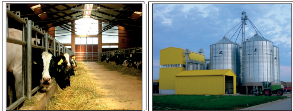
Slika 8. Bioplinsko postrojenje Ivankovo (1 MW e ): fermentacijom stajskog gnojiva dobiva se plin koji pogoni plinski motor-generator.
