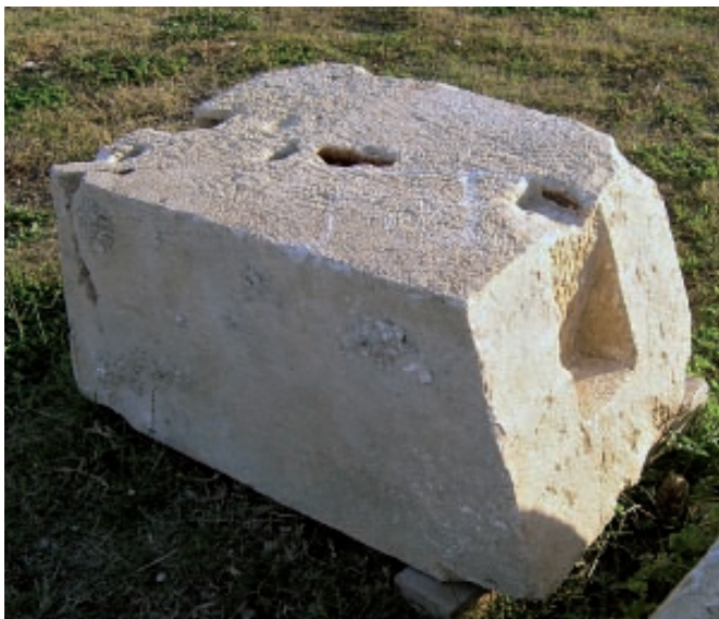
Slika 13. Jedan od neukrašenih kamenih blokova s anatrozom rubova i žljebovima za spojnice
