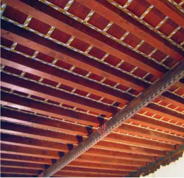
15 Rekonstruirani grednjak reprezentativne gotičke dvorane (foto: Anita Gamulin, 2008.)
