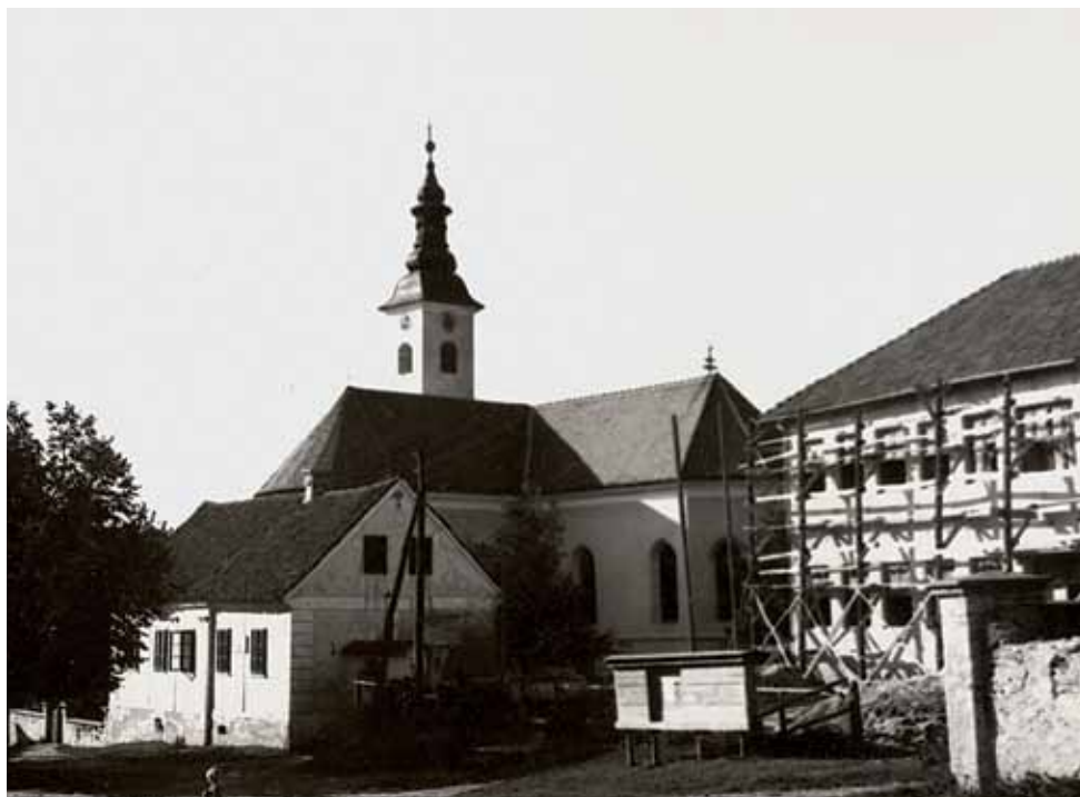
1 Pogled na crkvu, kapelanovu kuću i Dom kulture u izgradnji 1954. g. (Ministarstvo kulture, Uprava za kulturni razvitak, Odjel za INDOK poslove kulturne baštine, Fototeka kulturne baštine, inv. br.: 16135; neg.: II-3015)
