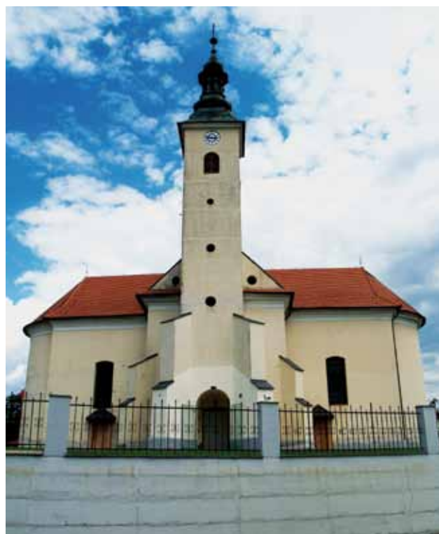
20 Pogled na zapadno pročelje (stanje 2010., foto: Marijana Korunek) View of the west elevation (2010, photo by Marijana Korunek)
