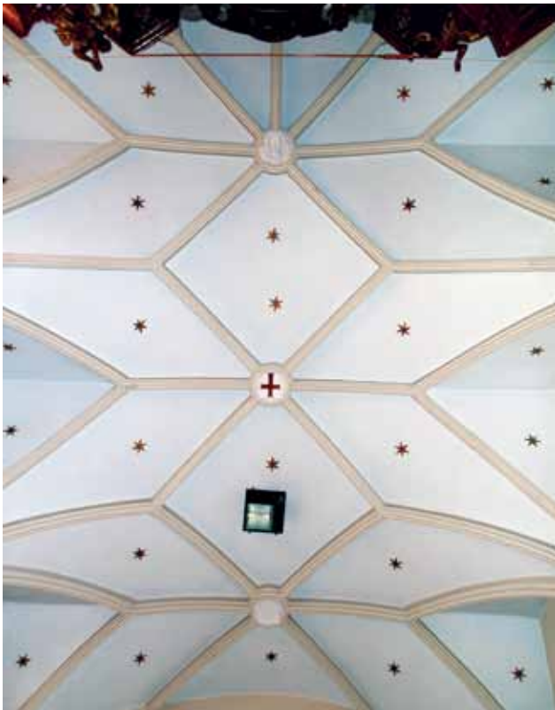
9 Unutrašnjost, pogled na gotički svod u svetištu (stanje 2010., foto: Marijana Korunek)
