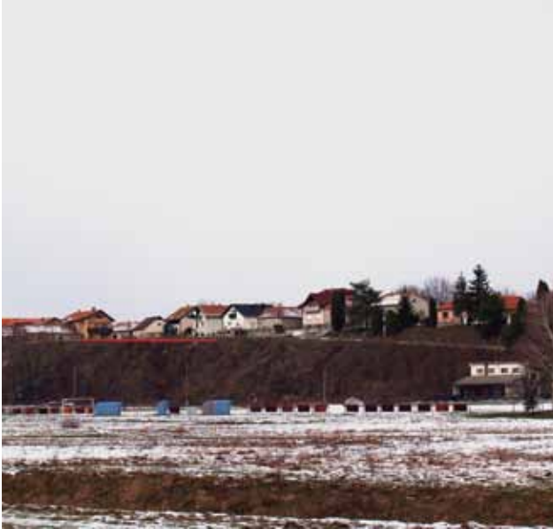
2 Lokacija srušene crkve sv. Mihovila Arhanđela u Mihovljanu, stanje 2010.
