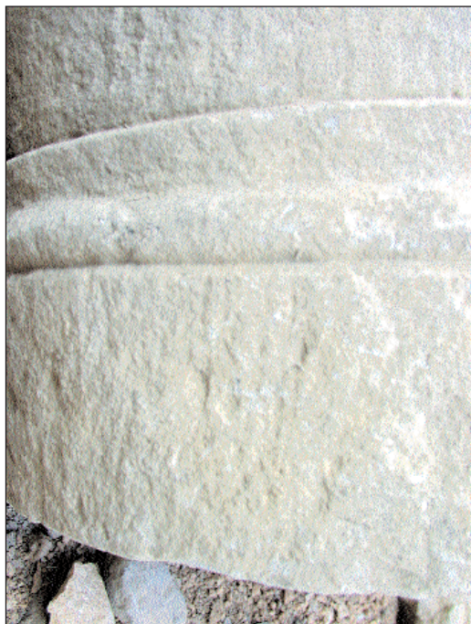
Sl. 1. Jednostruka profilacija baze i dvostruka profilacija donjeg dijela cilindričnog tijela Fig. 1. Single profile of a base and a double profile of the lower part of a cylindrical body
