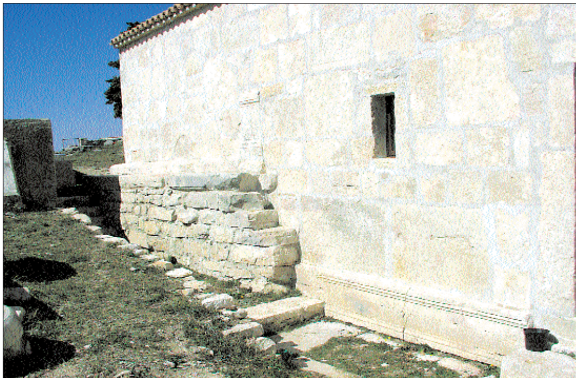
Sl. 1. Južna strana crkve Sv. Duha s vidljivim dijelom adaptacije zgrade iz kasnoantičkog razdoblja (narteks ranokršćanske crkve)
