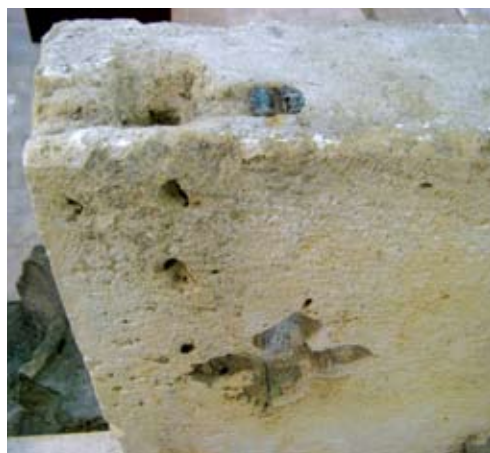
Detalj obrade stražnje strane i spone omiške ograde
