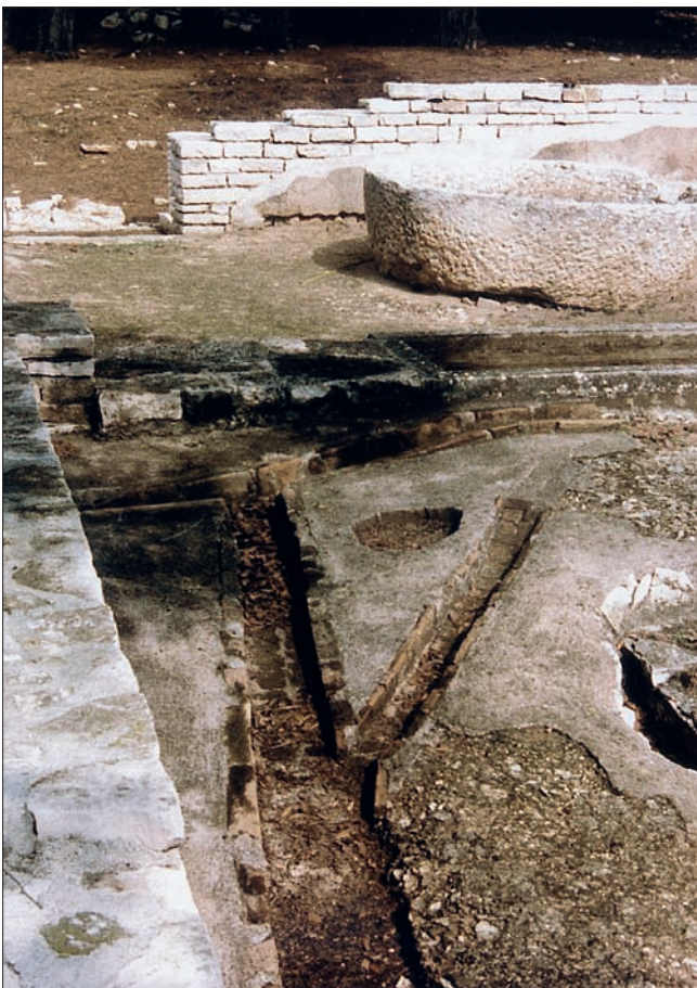
Sl. 8 Odvodni kanali izvedeni u tehnici opus spicatum u podu dvorišta
