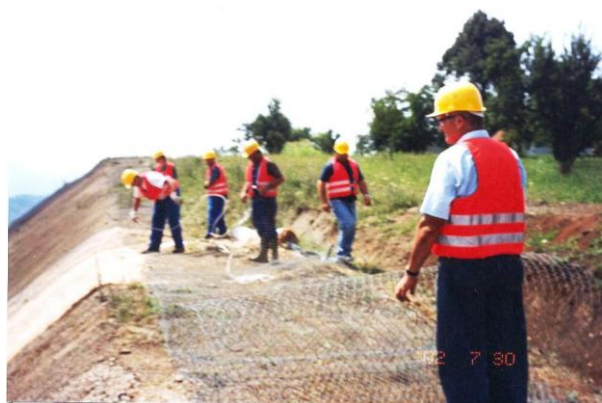
Slika 2. Postavljanje žičanih mreža na bioplatno
