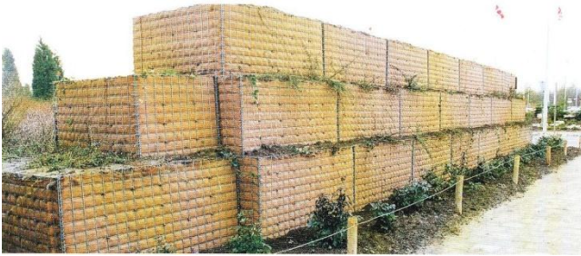
Slika 4. Gabionski zid za zaštitu od buke
