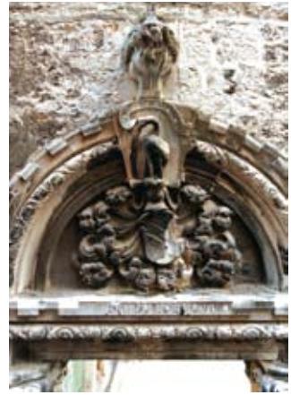
Portal palače D'Augubio
