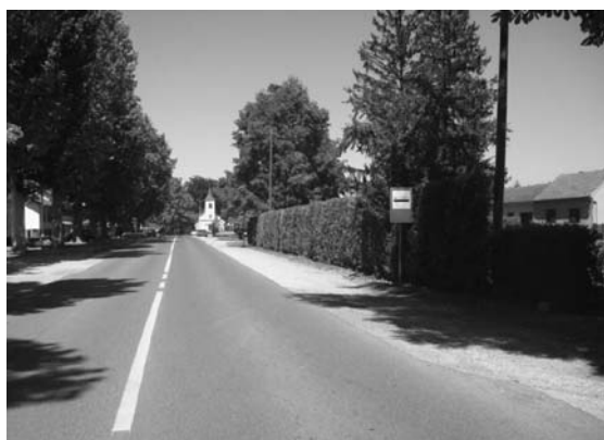
Slika 6. Nepravilno izvedeno autobusno stajalište Gornji grad
