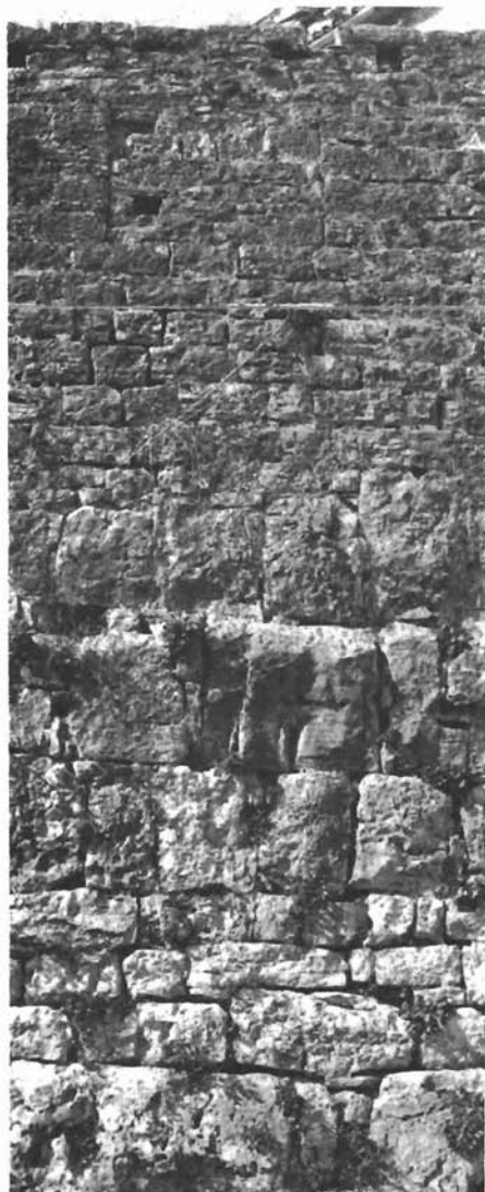
Sl. 2. Bale, pročelje kule južno od župne crkve
