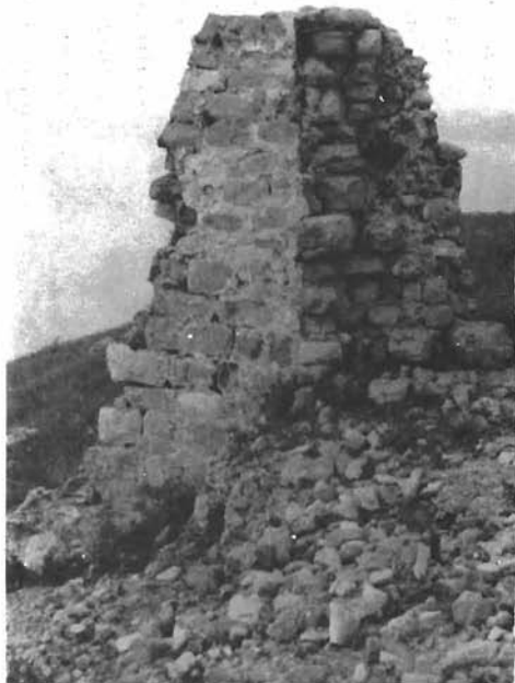
Sl. 3. Rt Ljubljana, ruševine crkve, kontrafor
