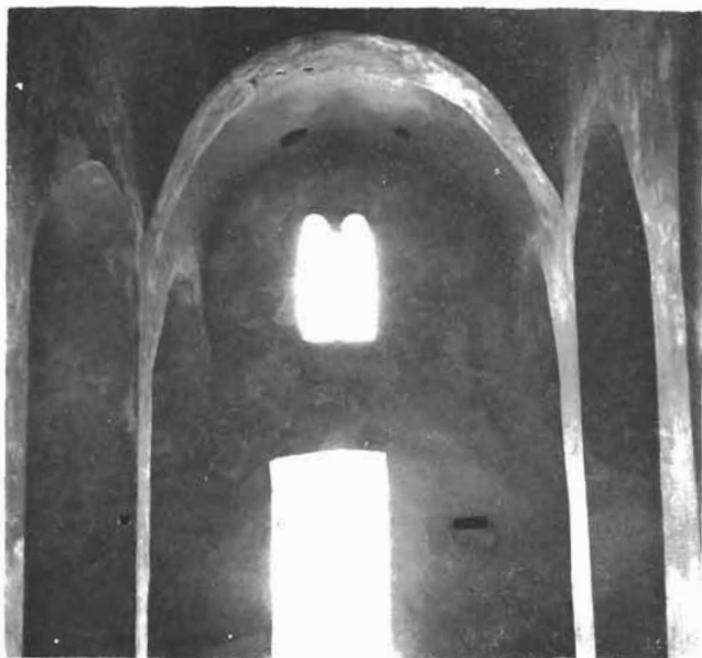
Obnovljena unutrašnjost crkve s pogledom prema pročelju
