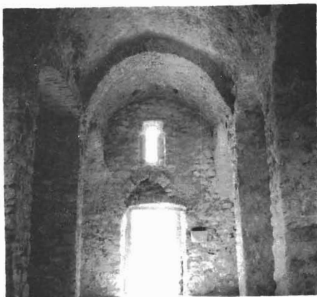
Unutrašnjost crkve nakon otucanja recentne žbuke. Pogled prema pročelju
