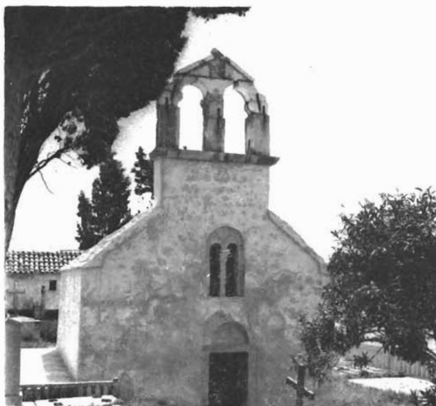
Pročelje crkve poslije obnove
