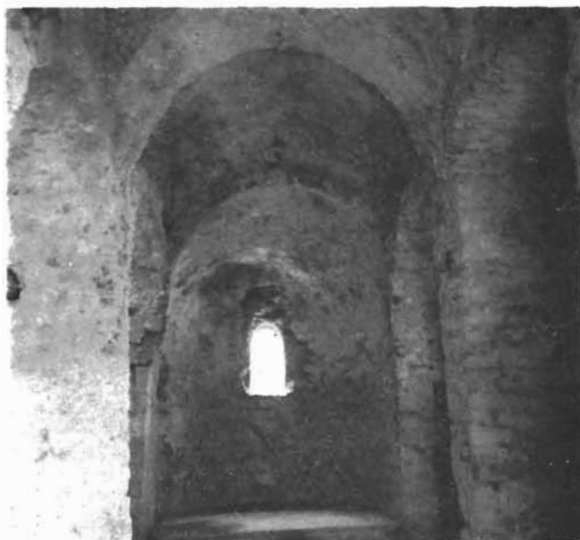
Unutrašnjost crkve nakon otucanja recentne žbuke. Pogled prema svetišću
