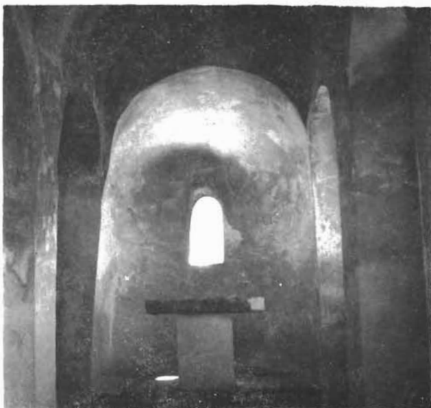
Obnovljena unutrašnjost crkve s pogledom prema svetištu
