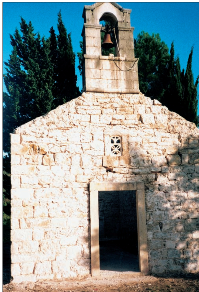
Sl. 2. Crkva Sv. Pavla, pročelje, Palje Brdo, Konavle (foto: don Željko Kovačević)
