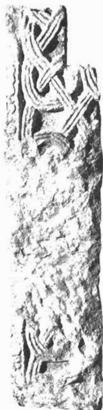
Sl. 1. Oštećeni pilastar oltarne pregrade
