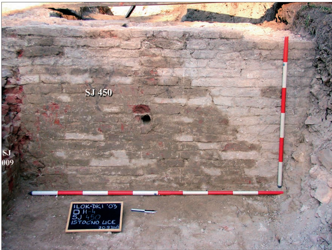
Sl. 14. Pogled na sjeverozapadni kontrafor palače (SJ 450)
