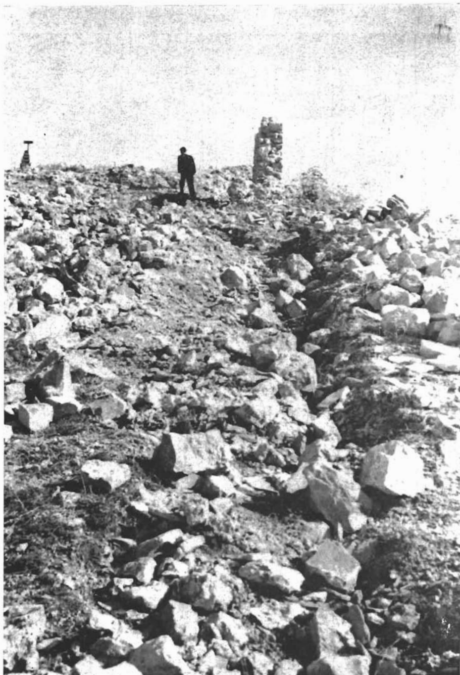
Sl. 19. Rušenje zidova do temelja g. 1951.
