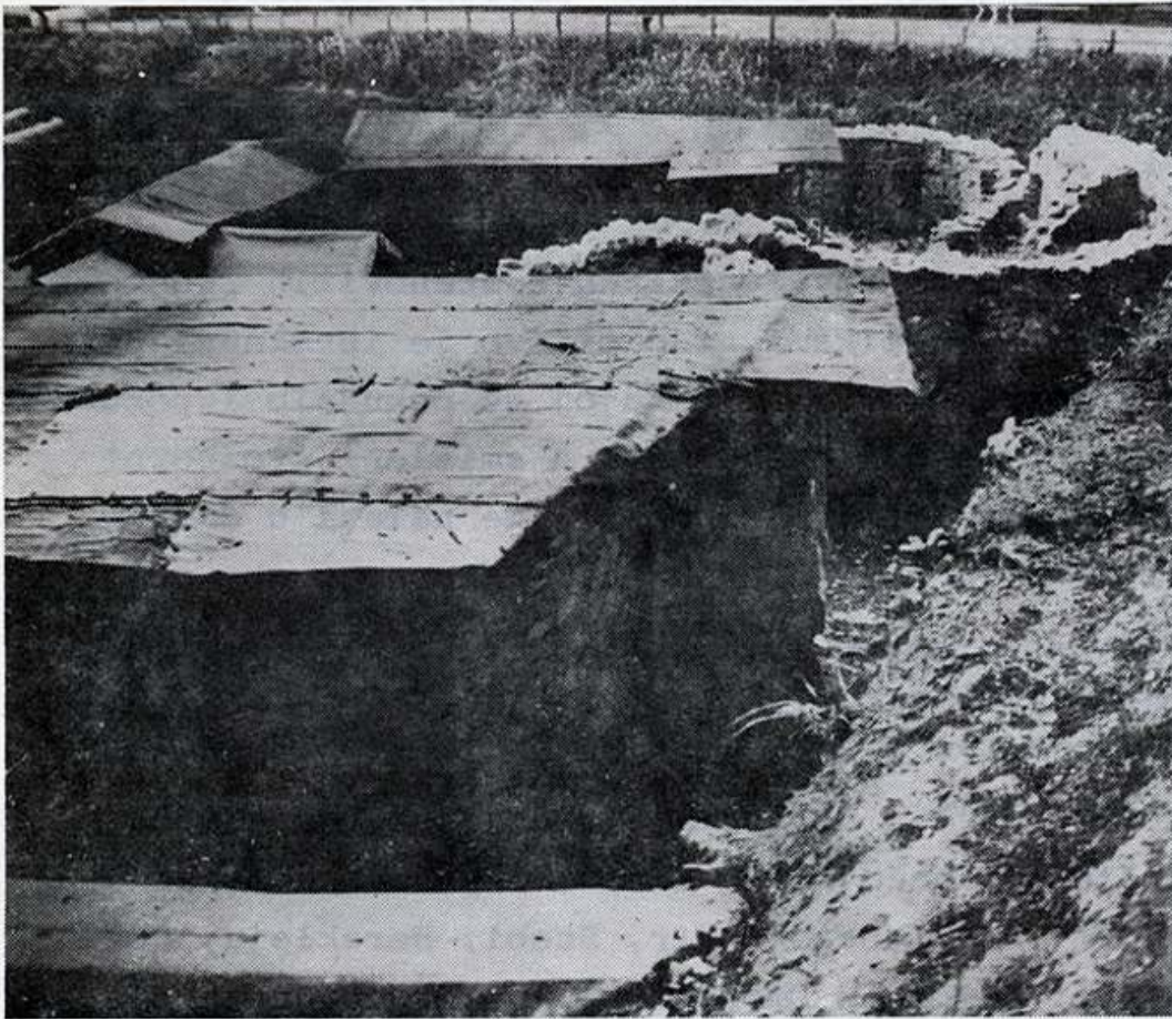
Varaždinske toplice - provizorna zaštita zidova u kompleksu rimskih termi
