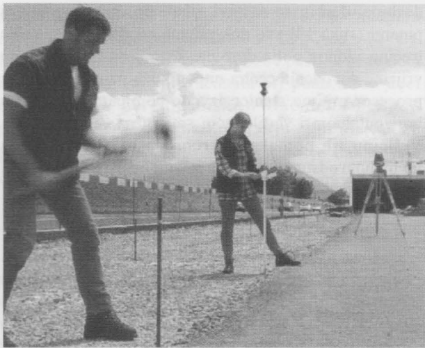
Slika 16. Mjeriteljica uz pomoć daljinskog upravljača-kontrolera RCS 1000, prizme 360š GRZ4 i automatske mjerne stanice Leica TCA 1100 samostalno iskolčava cestu.
