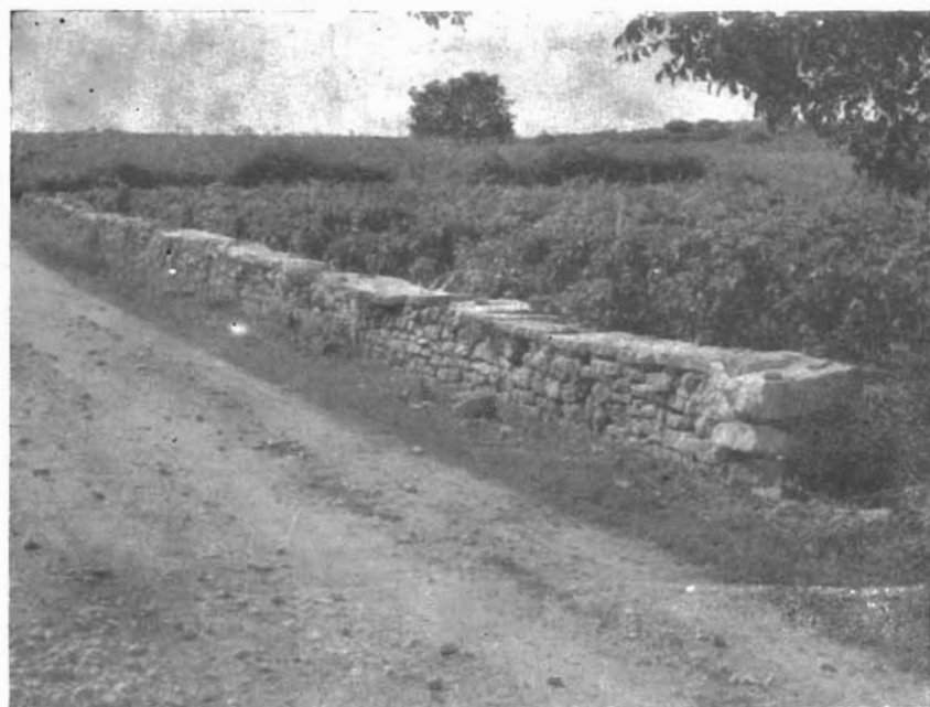
Sl. 6. Zidna konstrukcija oratorija Sl. 7. Konstrukcija današnjeg suhozida kod Mijovilovca
