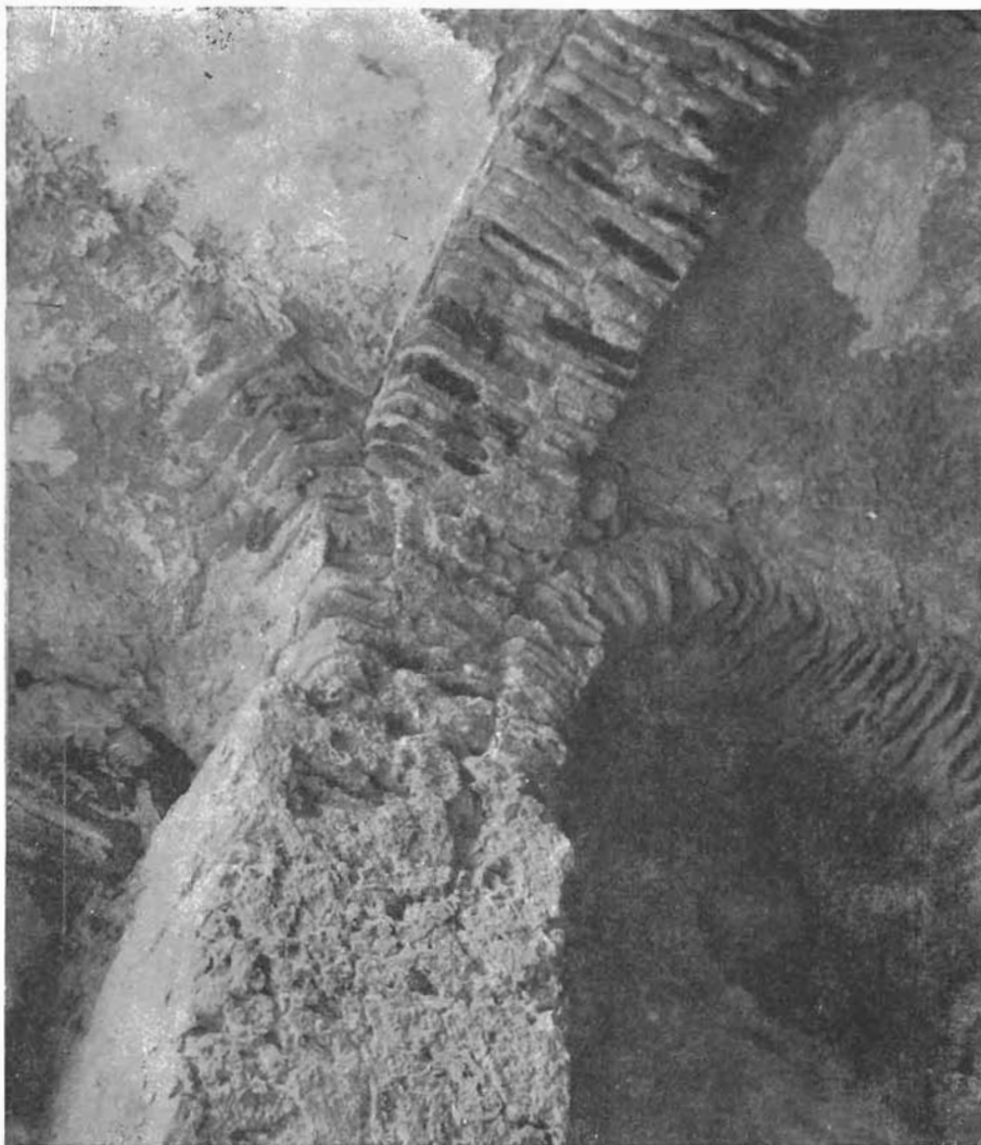
Sl. 4. Detalj konstrukcije svoda crkve sv. Nikole kraj Poveljane
