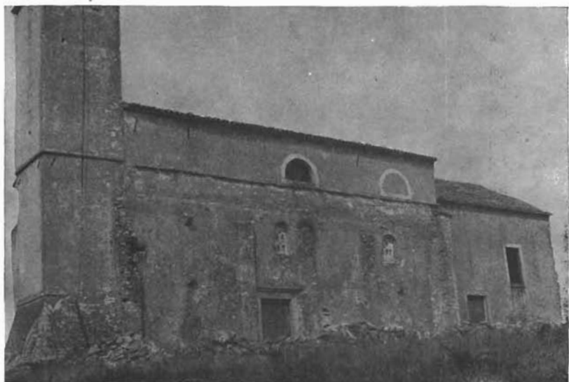
Sl. 5. Sv. Foška kod Žminja. Pogled na sjeverni zid i pročelje sa zvonikom. Sl. 6. Sv. Foška kod Žminja. Pogled na južni zid.
