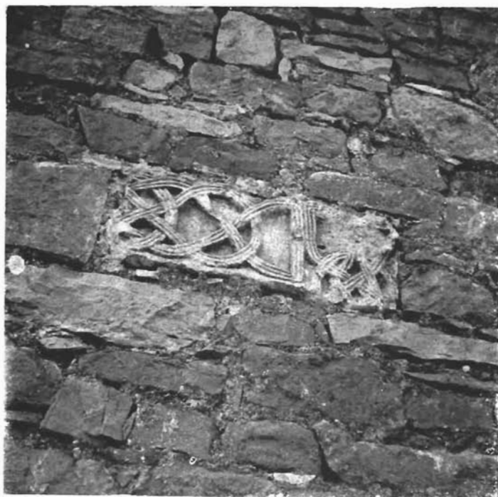
Sl. 29. Pilastar uzidan kao spolij u sjeverni zid crkve sv. Petra u Kuli kod Benkovca.
