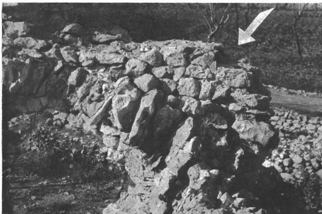
Sl. 9. Ostaci ulaznih vrata gornje crkve (strelicom označeno ležište dovratnika)
