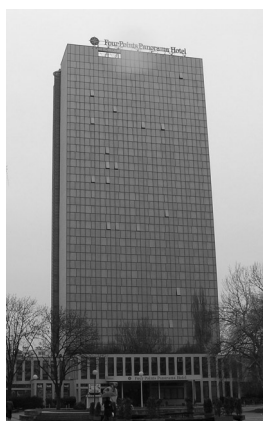
Slika 8. Pogled na rekonstruiranu fasadu hotela Panorama, Zagreb.
