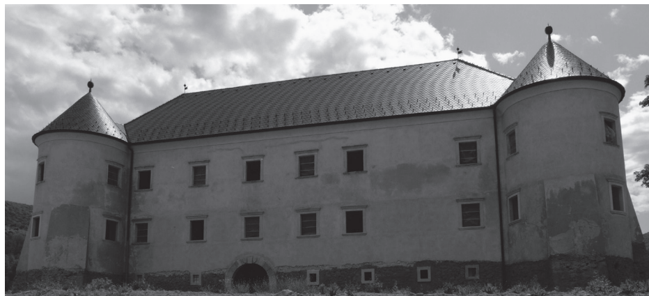
Slika 1. Dvorac Bela pokraj Ivanca u Hrvatskom zagorju (foto: O. Blagec)
