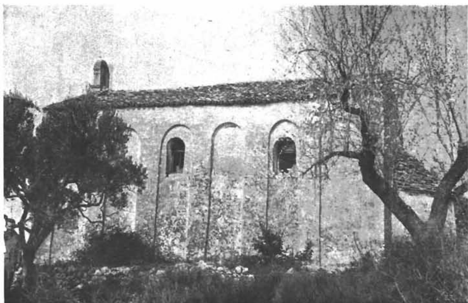
Sl. 17. Vanjska površina lijevoga bočnog zida crkve sv. Krištofa kod Rovinja
