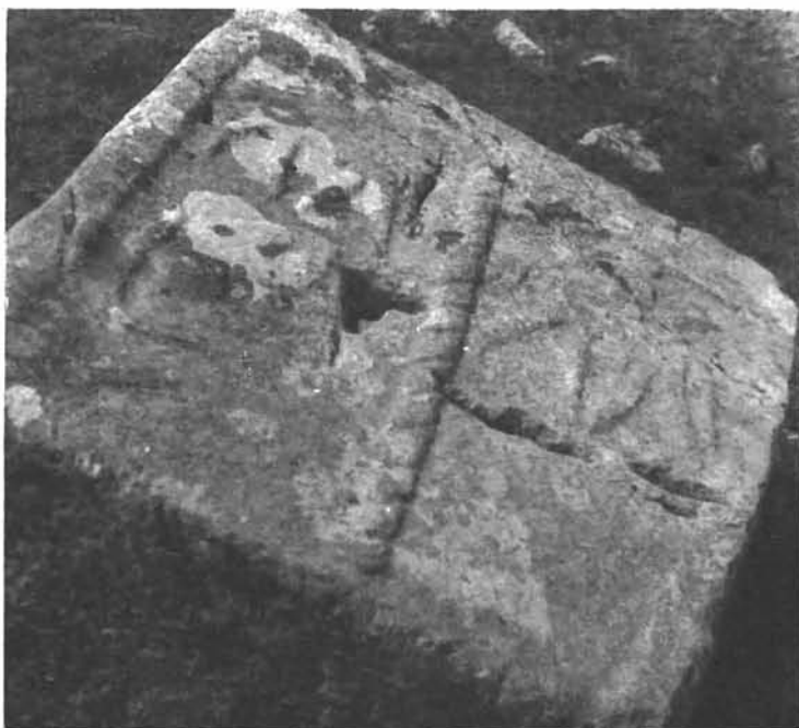
Sl. 16. Cista (Mala gomila). Primjerak narozanog stupca, koji dijeli fasadu u dva polja
