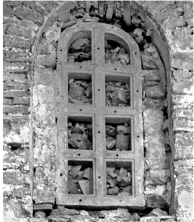
20. Tranzena na sjevernom zidu Window transenna in the north wall
