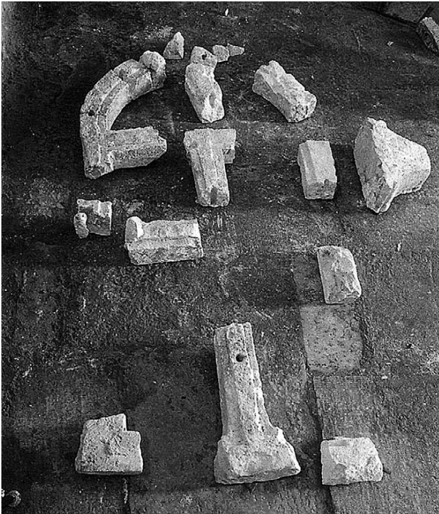
19. Ulomci tranzene iz sjevernog prozora apside Fragments of window transenna in the north window in the apse
