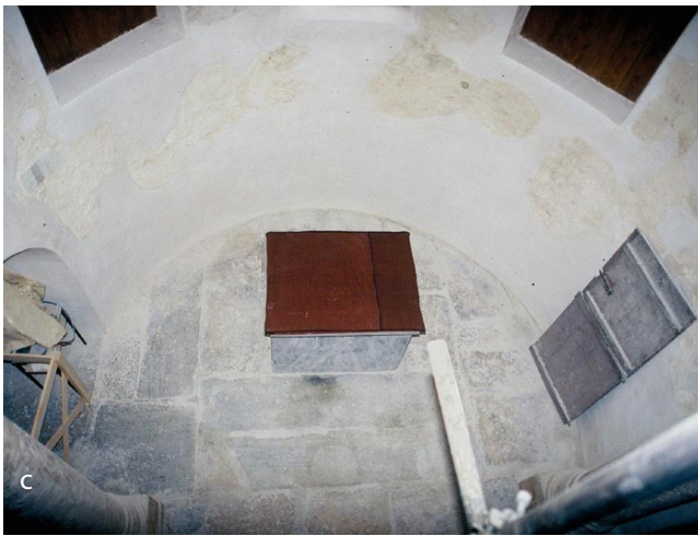
31. Istražno sondiranje, a) sonda na zidu u unutrašnjosti apside: 1. kamena građa zida, 2. prvi sloj žbuke, 3. nalič na prvom sloju, 4. drugi sloj žbuke, 5. dva ili tri sloja naliča; b) sonda na spoju zida priprate i jugozapadne lezene na pročelju crkve; c) unutrašnjost apside s konzerviranim i prezentiranim fragmentima izvorne pokrovne žbuke
