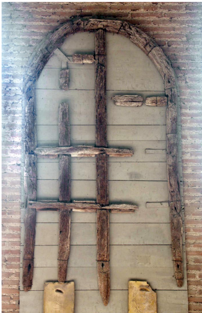
27. Drvena rešetka prozora iz crkve San Apolinare in Classe pokraj Ravene Wooden window lattice from Sant' Apollinare in Classe near Ravenna
