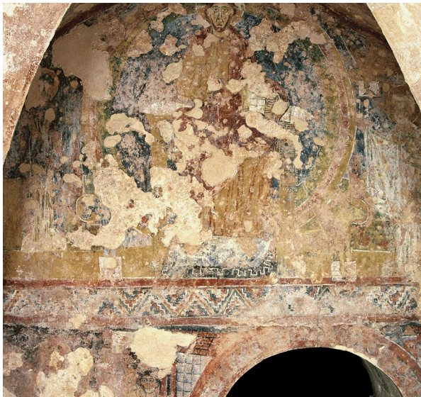
10. Zvonik crkve Sv. Marije, Zadar, jugoistočni zid, stanje prije završnog čišćenja razdjelne trake između lunete i donjeg dijela zida (fototeka HRZ-a, snimio I. Srša)
