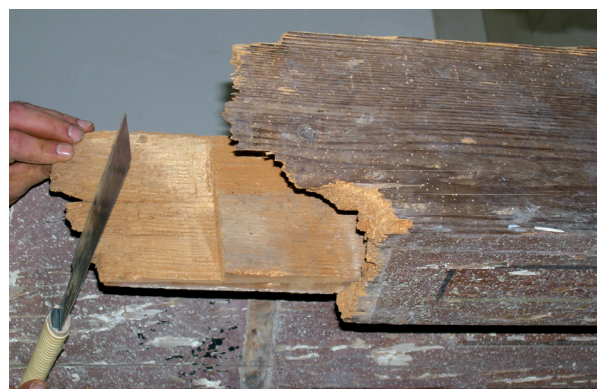
5. Stanjivanje oštećene drvene osnove (fototeka HRZ-a, snimila I. Koci)
