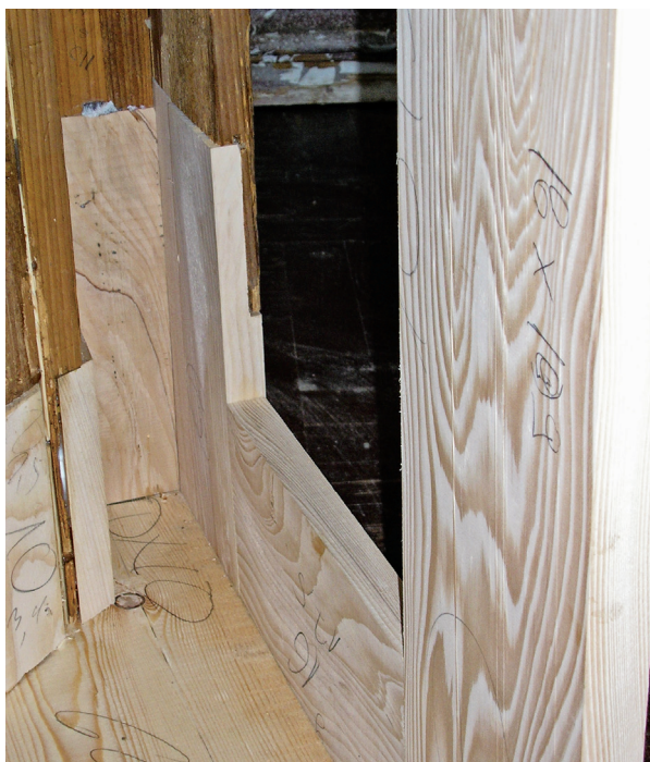
6. Novi dijelovi konstrukcije oltara (fototeka HRZ-a, snimila I. Koci) New elements of the altar structure (photographic archive of the HRZ, photo by I. Koci)
