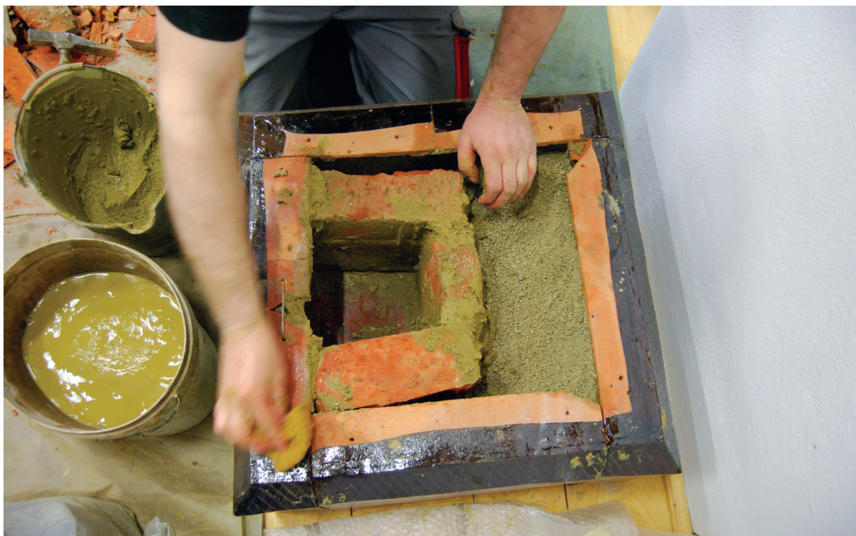
17. Smeđa peć, postupak ponovne montaže – zidanje temeljnog dijela (fototeka HRZ-a) The brown stove, reassembly – construction of the base (photographic archive of the HRZ)
