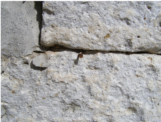
Sl. 12 Primjer željeznog čavla između dva kamena bloka Fig. 12 An example of an iron nail between two blocks of stone.
