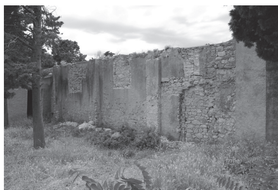
Fig. 8 Saint-Pierre d'Ilovik, vue du mur sud de l'ancienne basilique après l'ouverture des sondages archéologiques dans les élévations (cl. S. Bully, 2010)
