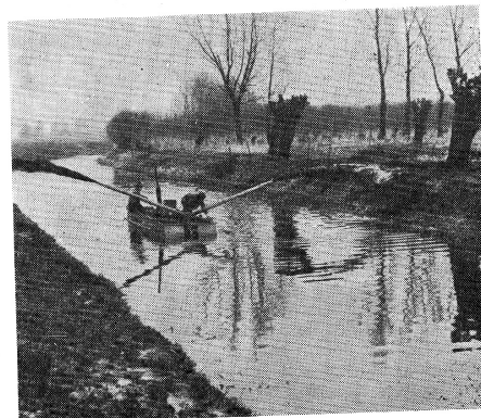
Sl. 6. Čamac za čišćenje kanala izbacuje mulj obostrano
