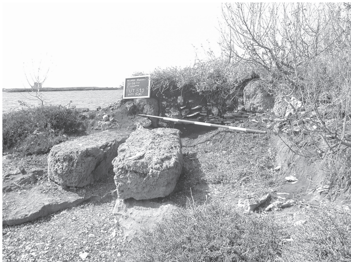
Fig. 4. Torre Guaceto (Br). Resti della fondazione e del crollo della presunta torre/faro sul terzo isolotto.
