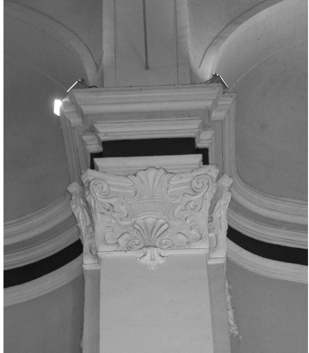
5. Varaždin, župna crkva sv. Nikole, kapitel u brodu (foto: D. Botica) / Varaždin, Parish church of St. Nicholas, nave capital (photo D. Botica)
