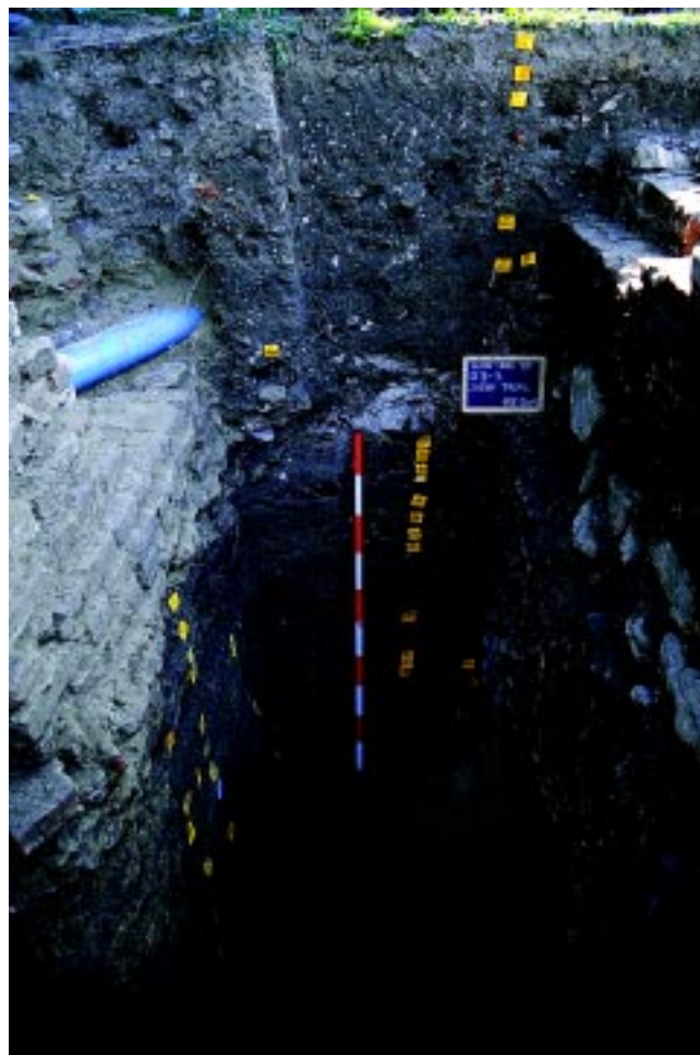
Sl. 4. Ilok. Gotički masivni zid objekta iz 15. stoljeća, građen od opeka, na podlozi od kamena lomljenca temeljenoj u sloju prapora. Snimio Ž. T.
