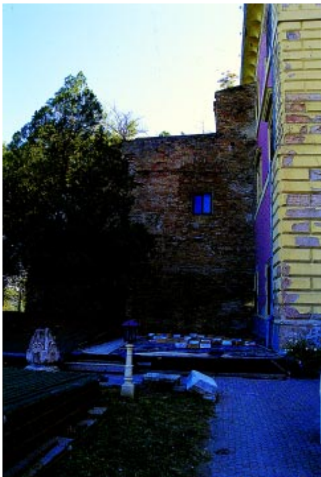
Sl. 5. Ilok. Dio srednjovjekovnog gotičkog zida očuvan do visine krovne konstrukcije palače u istočnom njezinom dijelu. Snimio Ž. T.
