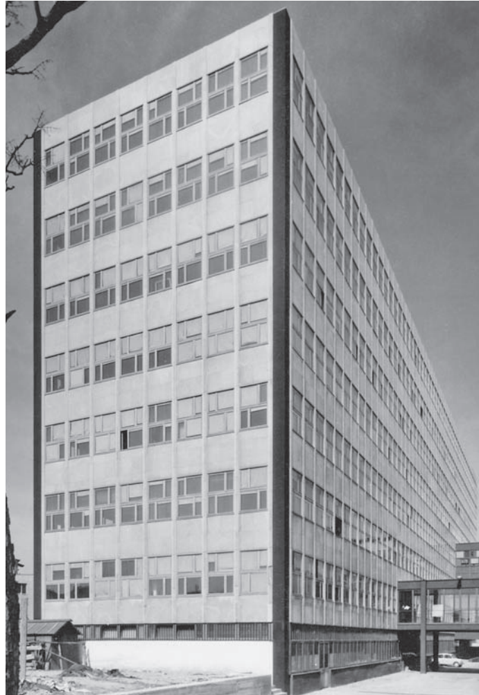
SL. 21. TEHNOLOŠKI FAKULTET, ZAGREB, POGLED NA MEDUPROSTOR IZMEĐU DVIJU ZGRADA
