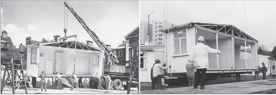
Sl. 3. POSLIJERATNE BRITANSKE ALUMINIJSKE KUĆE: MONTAŽA ISPRED TATE MODERN GALERIJE 1945., DEMONTAŽA KUĆE U LLANDINAM CRESCENTU ZA PREMJEŠTAJ U MUZEJ 1998.
