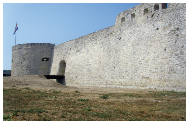
31. Kostajnica, pogled sa sjevera na ulaz u Stari grad nakon dovršetka radova (2011.) Kostajnica, the view from the northern entrance to the Old City after the completion of works (2011)
