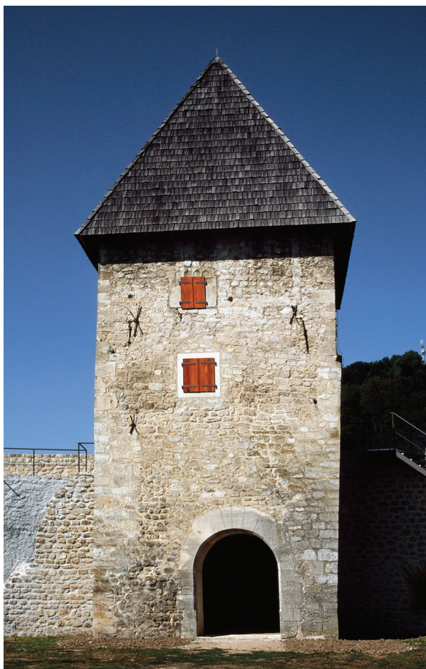
23. Pogled na četverokutnu kulu (2011.) View of the square tower (2011)
