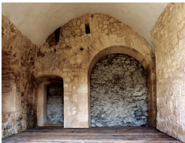
26. Prizemlje četverokutne kule, kolni i pješački ulaz (2011.) Ground floor square tower, vehicular and pedestrian entrance (2011)
