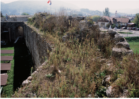
20. Kostajnica, Stari grad, krunište južnog obrambenog zida prije radova
